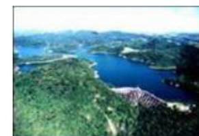
HPP Fontes Nova 132 MW
