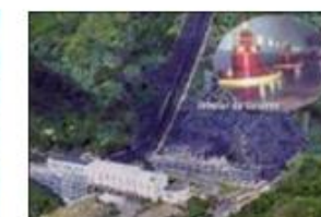
Underground HPP Nilo Peçanha 380 MW
